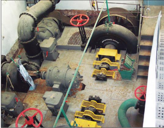
La Cámara de Bombas es paso obligado hacia la Sala IV y se ha incorporado al recorrido por entenderse que éste quedaría incompleto si no mostrase una instalación industrial a escala real. Rehabilitada en 1990, consta de tres bombas principales para el achique del dique y dos para el achique de la sentina. Los equipos aún están operativos.
